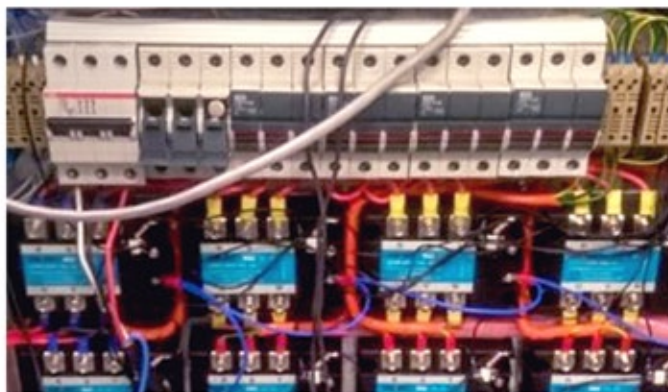
Внутреннее устройство блока ИМПУЛЬС-БКН
